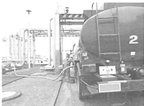
簡易保全工事（油回収）
